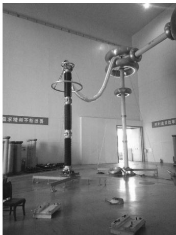
图3 试验现场图 Fig. 3 The field test
